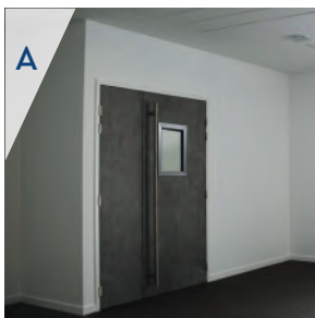
A : Bloc-porte 2V EI30 SPF avec parclose affleurante 300x400mm.
