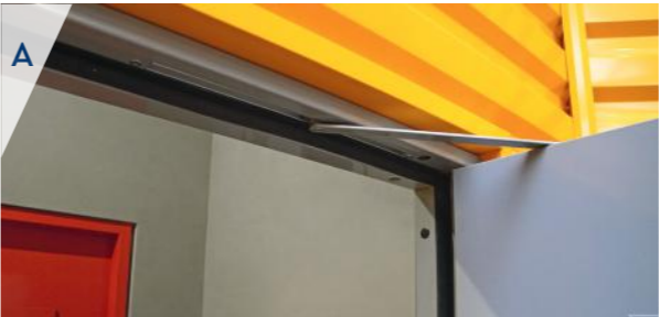
A : Bloc-porte avec ferme-porte encastré vue porte ouverte côté opposé aux paumelles B : Bloc-porte avec ferme-porte encastré vue porte fermée côté paumelles C : Version avec ferme-porte en applique
